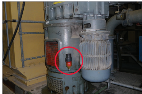
Industrie: centrales électriques
